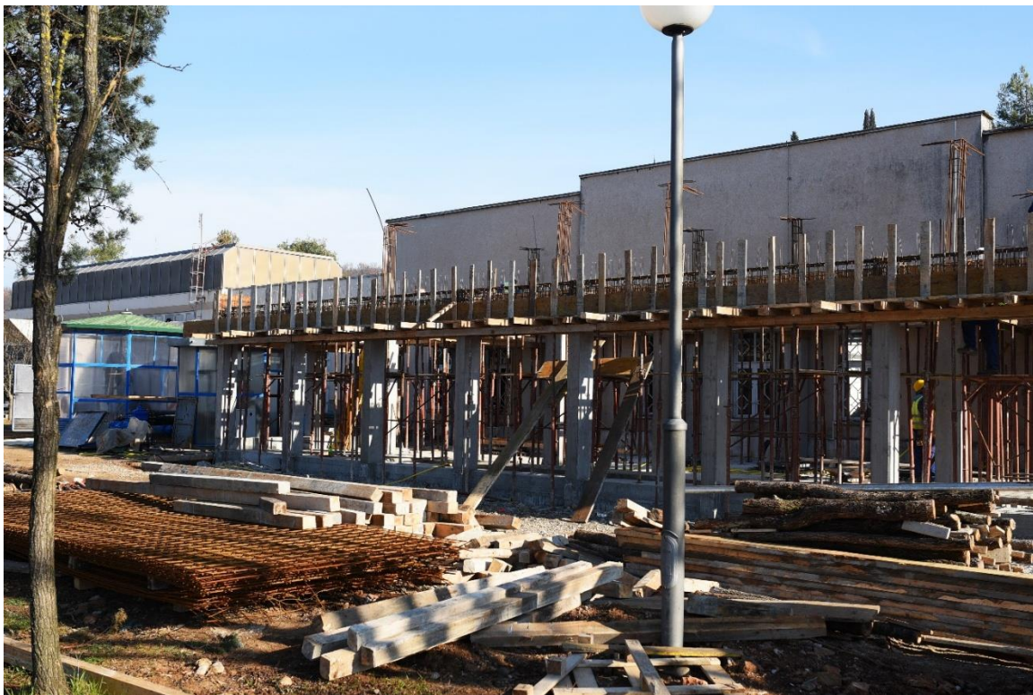
Radovi na rekonstrukciji CS“Mareza 1“
